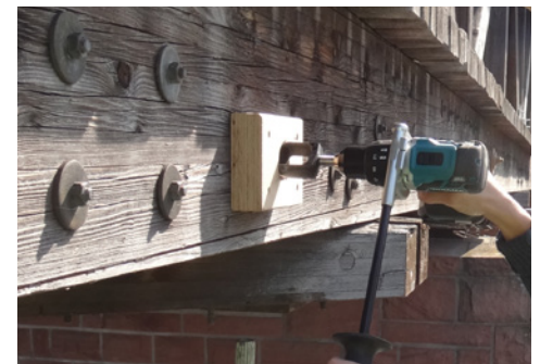
Abb. 3: Führung des Zapfenbohrers / Scheibenschneiders mit einer Bohrschablone
