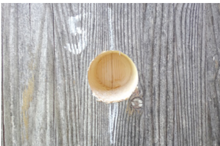
Abb. 1: Entnahmestelle in einem BS-Holzbauteil
