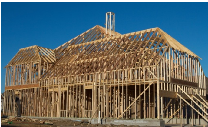
Quelle: www.hausjournal.net , Neubau in Ständerbauweise
