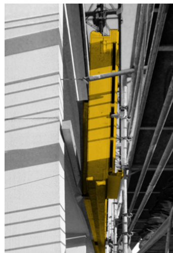
Abb. 77: Ablassen des Elements zwischen Bestand und Gerüst
