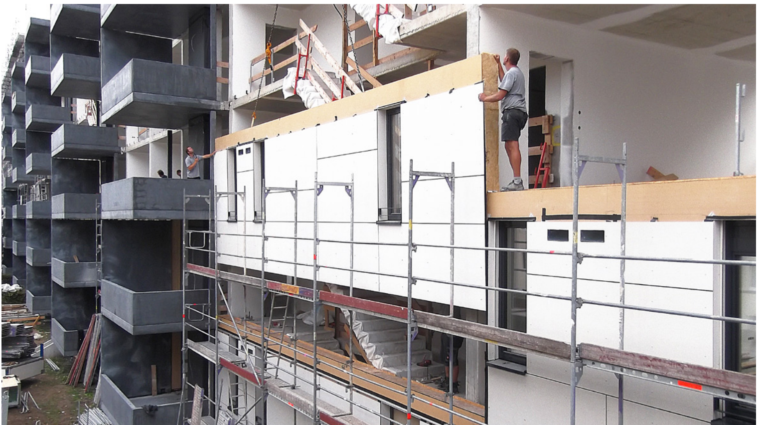
Abb. 3: Montage eines vorgefertigten Fassadenelementes
