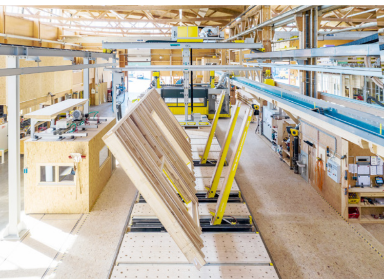
Abb. 7: Elementfertigung im Werk
