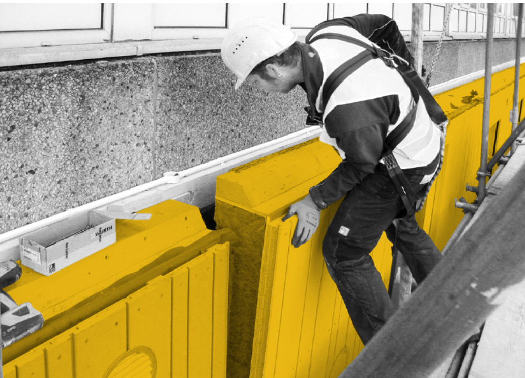
Abb. 40: Montage Fassade, horizontaler Stoß
