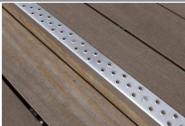
Abb. 2: Beispiel für einen mechanischen Rutschhemmer (profilierter Blechstreifen) an einer Stufenvorderkante
